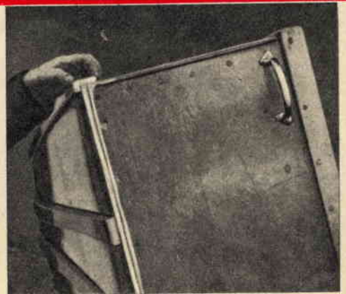
Fig.2 - In figura si nota come, per rinforzare il fondo dello scafo, siano stati applicati dei righelli longitudinali. Due maniglie nella parte anteriore e due in quella posteriore permettono un comodo trasporto dello scafo a terra.
